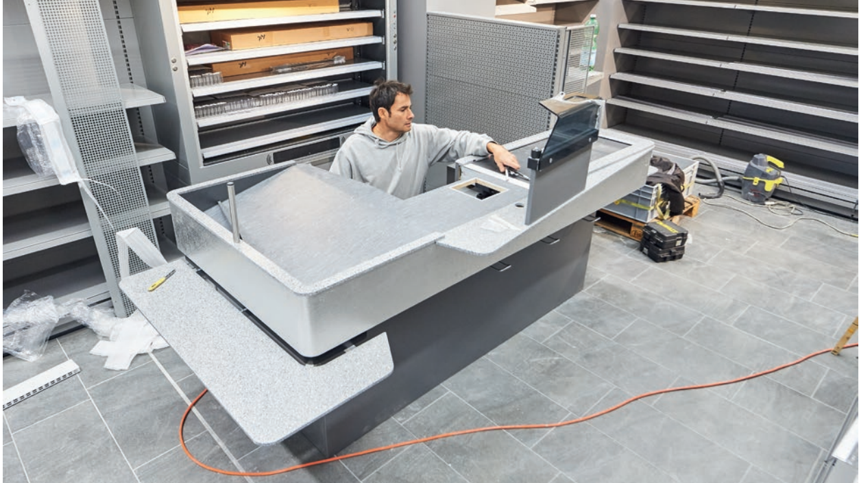
Passgenau: Bei der Montage der neuen Kassenstation ist viel Handarbeit gefragt.
