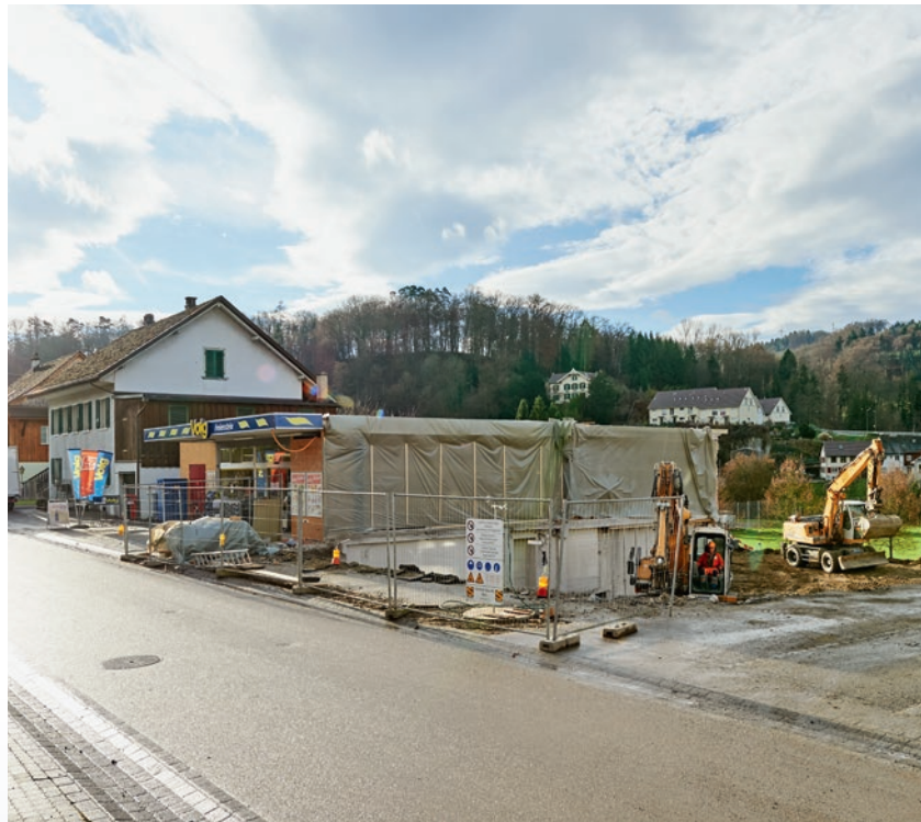
Die Bagger fahren auf: Mitte Dezember 2014 starteten die Bauarbeiten für den neuen Volg-Laden in Freienstein ZH.
