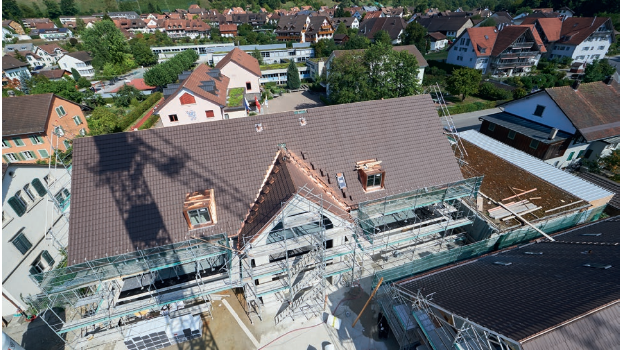
Blick von oben: Der Neubau mit Volg-Laden, Miet- und Eigentumswohnungen.
