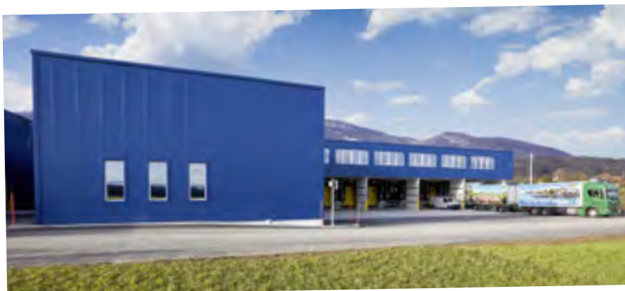
Auf dem Dach des Erweiterungsbaus in Oberbipp befindet sich eine Photovoltaikanlage mit über 4200 Solarmodulen.
