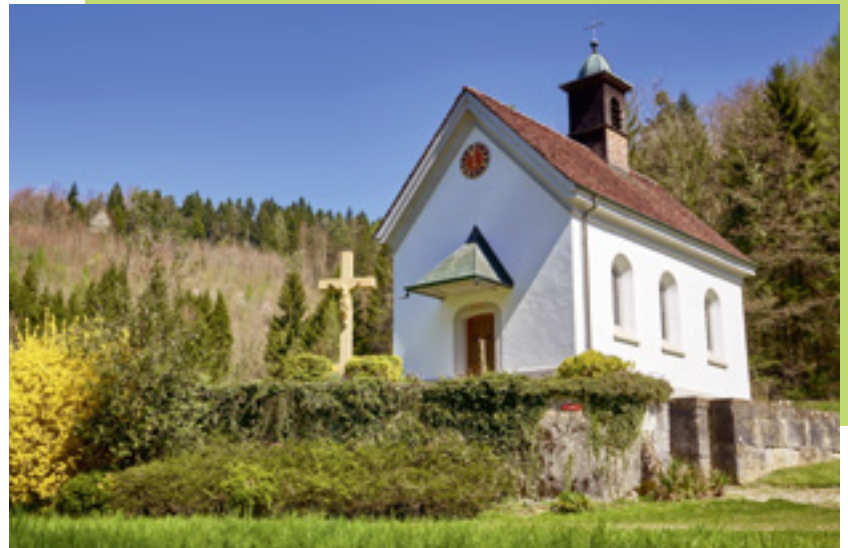
Zwischen Laufenburg und Sulz befindet sich die 1753 erbaute Nikolauskapelle – einst die Privatkapelle des örtlichen Müllers.
