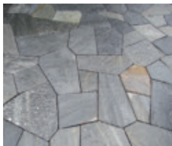
Seebachtal: Verlegen von Natursteinplatten
