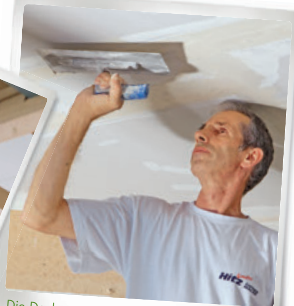
Die Decke wird neu verputzt und erhält später einen neuen Anstrich.
