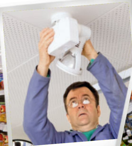
Die Lampen werden demontiert und durch LED-Spots ersetzt.
